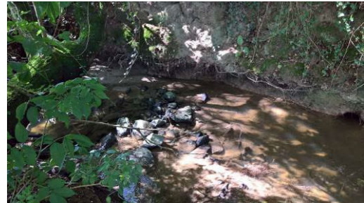
Radier et blocs
